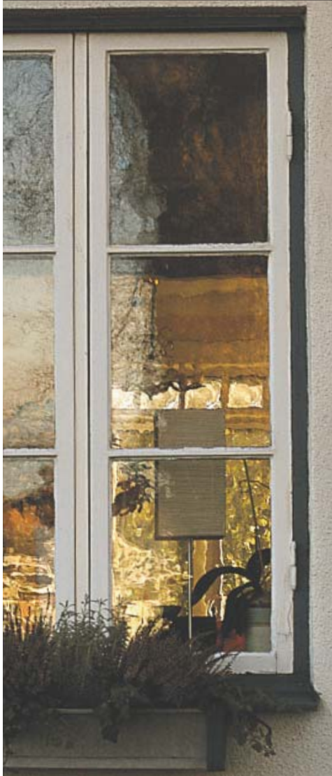
fönsterspecialisten. Villan är från 20-talet och om man inte heller inte byta modell på fönstren. Helena Bülow-Hübe blir glad fönster tänkt på det arkitektoniska och till exempel bemödat samma indelning som de gamla.
