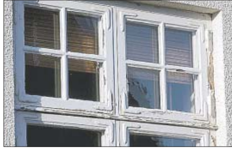
När man skrapar på ytan döljer sig många gånger bra virkeskvalitet. Trots att fönstren ser sjabbiga ut blir de, efter lite bearbetning och färg, som nya igen. Gamla träfönster är det ofta lönt att renovera, konstaterar Helena Bülow-Hübe.
