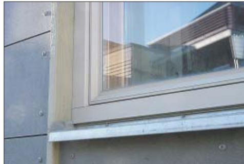
Många stora kommunala bostadsbolag satsar på aluminiumbekladda fönster. Det finns både för- och nackdelar med modellen, konstaterar Helena Bülow-Hübe. – Bara för att det är aluminium ska man inte tro att det håller i en evighet, säger hon.
